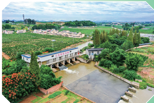
▲位于四川省眉山市彭山区境内的通济堰灌区江鱼堤泄洪闸 姚永亮/摄
