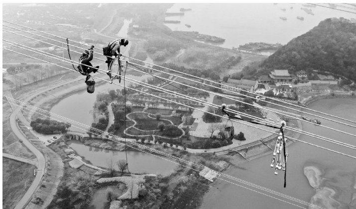
>> 正在建设的白鹤滩——江苏±800千伏特高压直流输电工程是我国“西电东送”战略的重点工程。图为2022年3月18日，安徽省芜湖市长江边，施工人员进行该线跨江作业 陈效宝/摄
