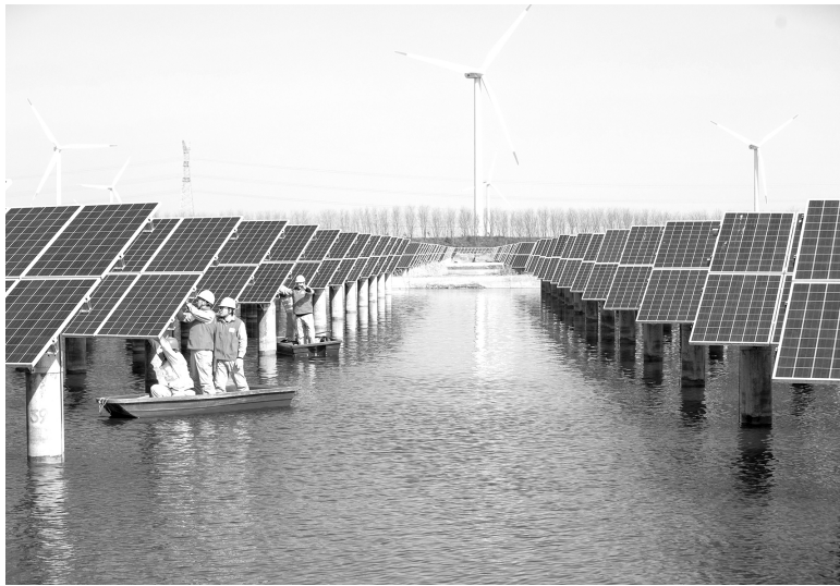
>> 江苏省海安市滨海新区在沿海开发中，运用滩涂资源培育壮大太阳能、风能等新能源产业，通过“渔光互补”实现水上发电、水下养鱼。图为电力工人在光伏电站巡检 翟慧勇/摄
