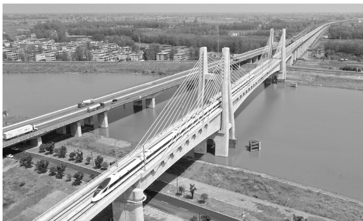
>> 复兴号行驶在安徽省阜阳市颍上特大桥上 罗春晓/摄
