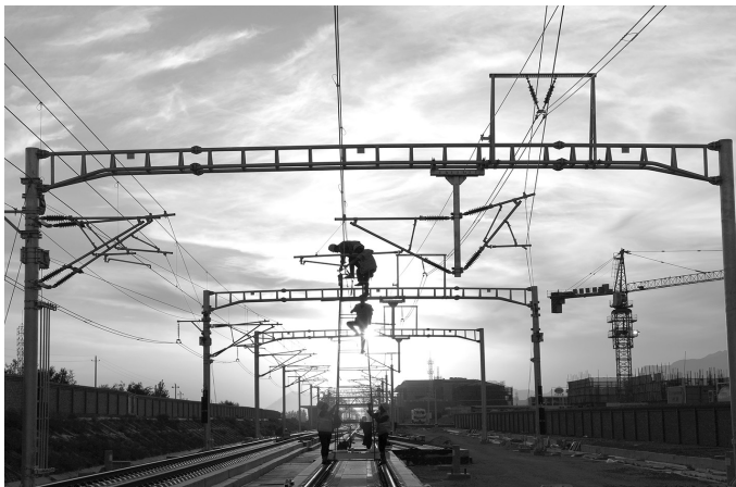
>> 工人在检修高铁电缆 李忠民/摄
