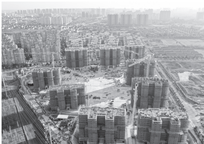
>> 2022年12月24日，江苏省如皋市一新建保障性住房项目在抓紧施工 徐慧/摄
