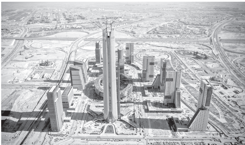
>> 中国建设的埃及新行政首都CBD项目航拍全景
