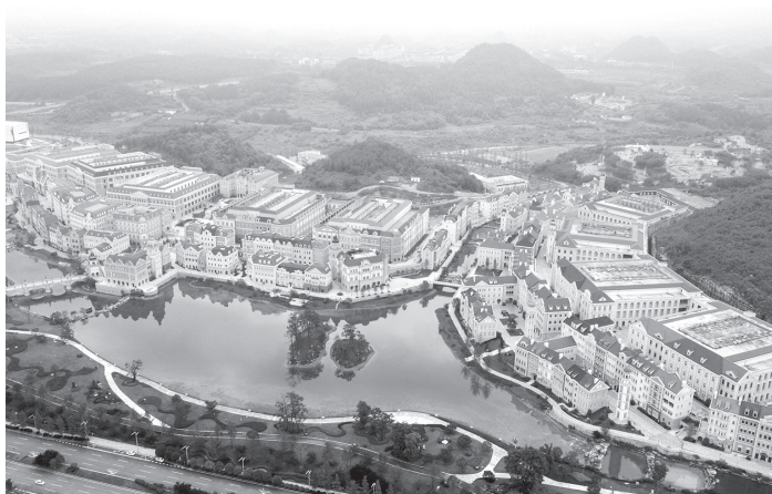
>> 贵州省大力推动大数据产业发展，涉及政务、商用、民用多个领域，给民众生产、生活方式带来显著改变。图为贵安新区华为云数据中心 欧东衢/摄
