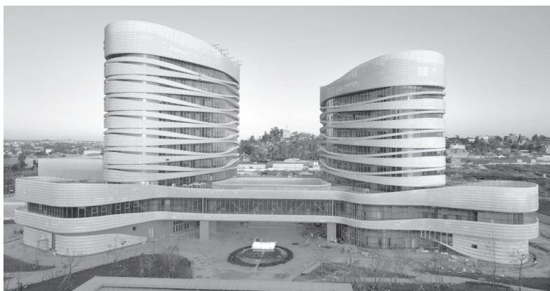
>> 由中国援建的非洲疾控中心总部项目是继非盟会议中心后中非合作的又一标志性项目。图为位于埃塞俄比亚首都亚的斯亚贝巴的非洲疾控中心总部大楼 党洪来/摄
