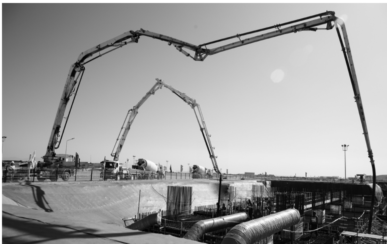
>> 胡努特鲁电厂项目是“一带一路”倡议和土耳其“中间走廊”计划对接的重点项目，2019年9月22日，该项目在土南部阿达纳省正式开工。图为项目主厂房浇筑混凝土作业现场 郑思远 / 摄
