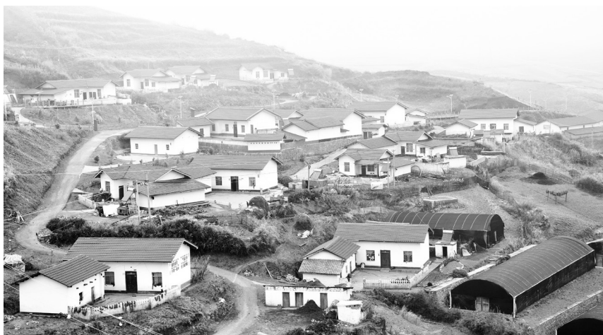
>> 四川省凉山州昭觉县解放乡火普村是易地扶贫搬迁的新村。图为火普村彝家新寨 张浪/摄
