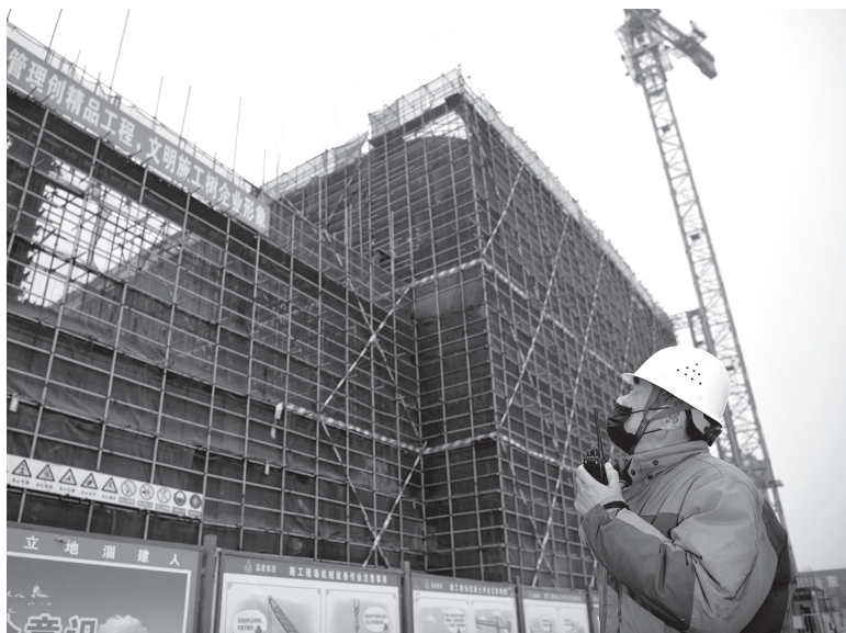
>> 2020年2月20日，在建的天津市西青生活垃圾综合处理厂项目复工建设。图为工作人员在建设现场指挥塔吊作业 李然/摄
