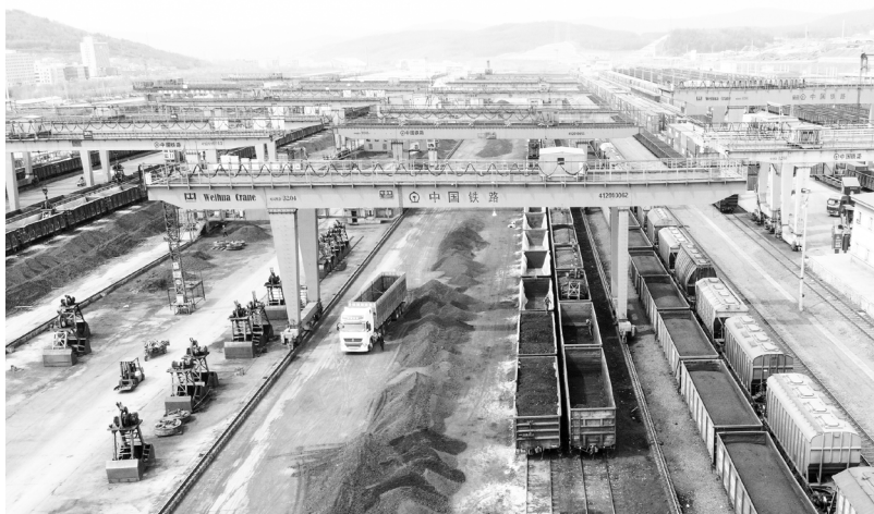
>> 2020年4月18日，无人机拍摄的绥芬河铁路口岸换装现场，等待换装的俄罗斯货运车体 新华社/发
