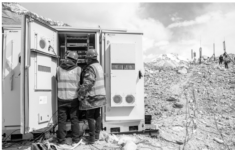
>> 2020年4月30日，中国移动在珠穆朗玛峰海拔6500米前进营地开通的5G基站投入使用，这是目前全球海拔最高的5G基站。图为工作人员在珠峰大本营附近调试5G基站信号 孙非 / 摄
