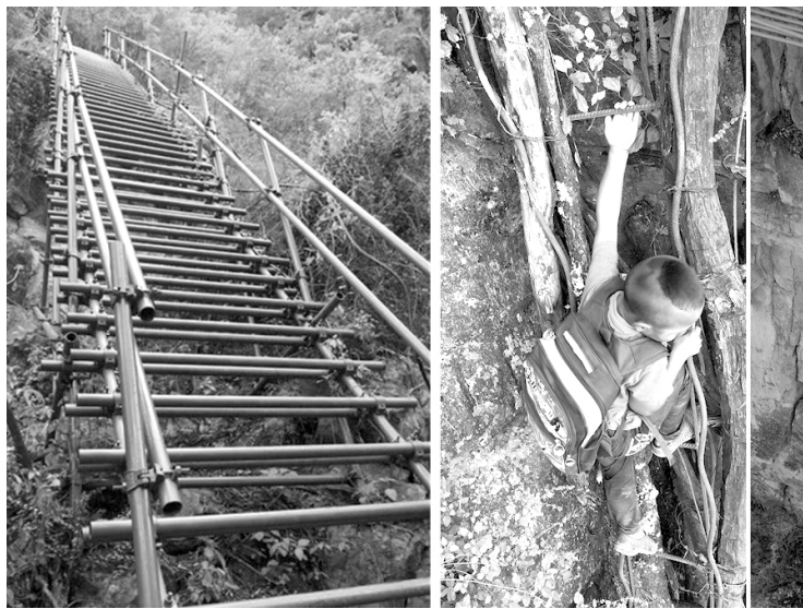
>> 藤梯升级为钢梯后，“悬崖村”的出行条件得到很大改善。左图为新修建的钢梯，右图为过去使用的藤梯 江宏景/摄
