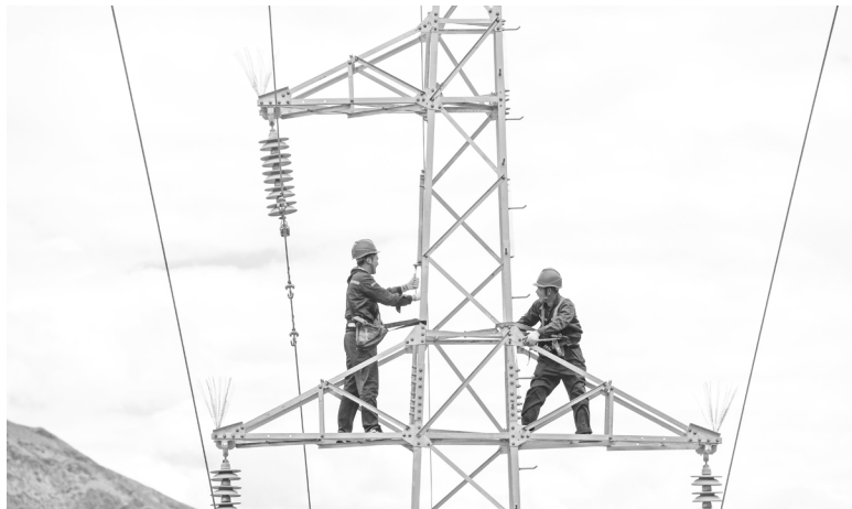
>> 2020年6月30日，位于西藏自治区山南市措美县海拔4800多米的35千伏乃西输变电工程建成投运，标志着西藏山南市“三区三州”深度贫困地区电网建设64项工程全部投运，500多户藏牧民生产生活用电也将实现升级。图为工作人员在进行投运前检查 宋卫星 / 摄
