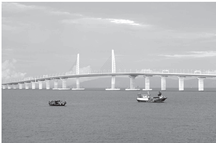
>> 党的十八大以来，我国经济社会发展取得辉煌成就。2018年建成通车的港珠澳大桥，被誉为“新的世界七大奇迹之一”，彰显了我国的综合国力和自主创新能力。图为港珠澳大桥一景 陈晔华/摄
