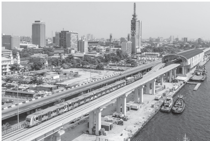
>> 2023年9月4日，尼日利亚拉各斯轻轨蓝线项目一期开通商业运行，这是西非第一条由中国企业自主设计、建造、施工、运营的电气化城市轻轨项目 新华社/发
