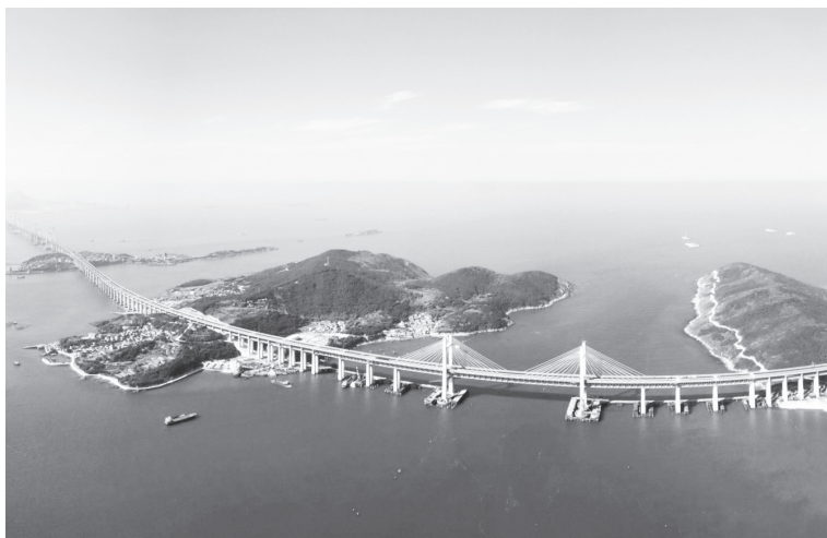
>> 福建平潭海峡公铁大桥全长16.34公里，是我国首座、世界最长的跨海公铁两用桥 王东明/摄
