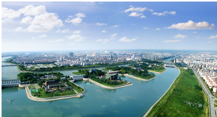
南水北调东线源头——江都水利枢纽
