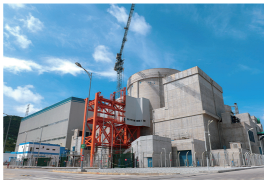
2018年7月13日，广东阳江核电站5号机组顺利完成168小时示范运行，其数字化仪控系统采用中国自主研发的“和睦系统”，实现核电站“神经中枢”中国造。中国成为继美国、法国、日本之后，第四个掌握该技术的国家
