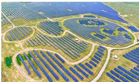
位于山西大同的熊猫形状的光伏电站 曹阳/摄
