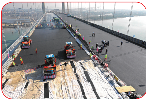
▲ 2019年1月30日，主桥钢桥面环氧沥青铺装工程完成
