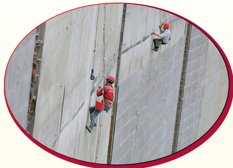
▲工人们在乌东德大坝施工现场
