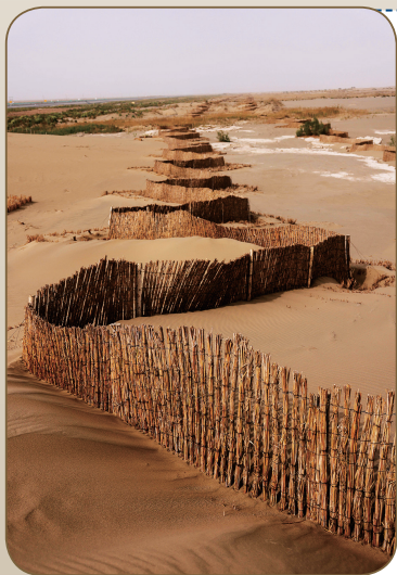
▲ 铁路沿线1.5米高的立式沙障
