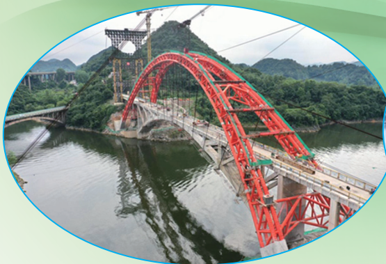
▲利用新拱扣挂住旧桥,准备拆除
