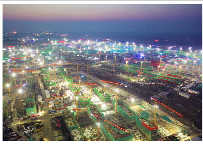
中国经济从新冠肺炎疫情危机中迅速复苏，继续成为全球经济增长的重要引擎。图为2020年9月24日拍摄的雄安新区容东片区安置房项目建设工地 邢广利/摄
