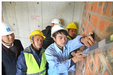
邹彬砌的墙，纵横两向的灰缝都能控制在1厘米标准以内。图为2018年2月8日，邹彬在工地上给工友“打样” 新华社/发
