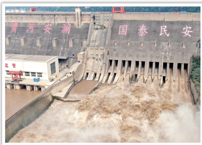
三门峡水利枢纽位于黄河中游下段，是新中国成立后在黄河上兴建的第一座以防洪为主，兼顾防凌、灌溉、供水、发电等任务的大型综合性水利枢纽工程 郝源/摄
