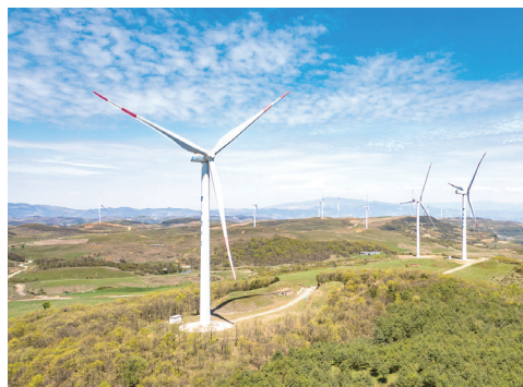
贵州省毕节市威宁彝族回族苗族自治县雪山镇的风力发电设备（无人机照片） 陶亮/摄
