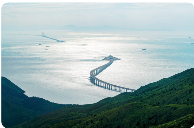
2018年10月24日，港珠澳大桥正式通车。图为从香港大屿山远眺港珠澳大桥
