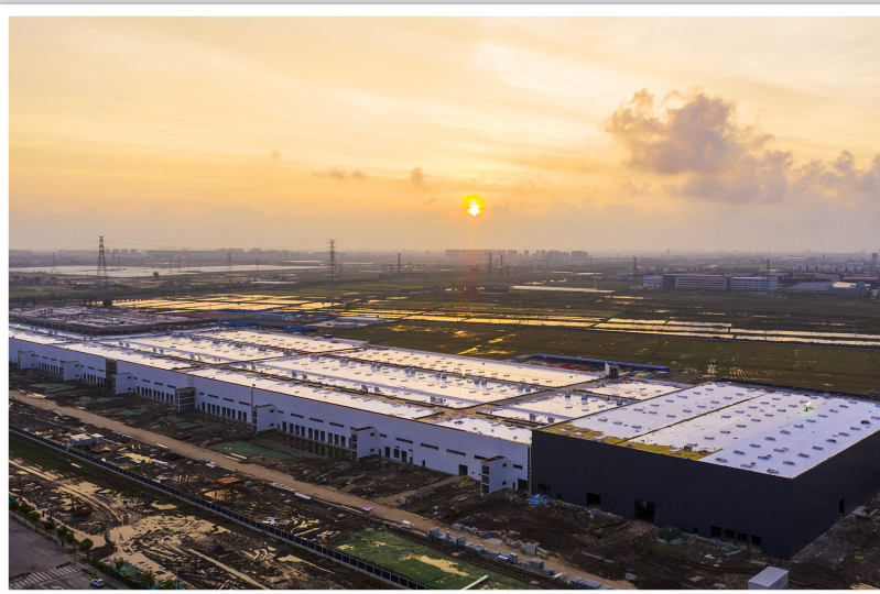
特斯拉上海超级工厂厂房2019年初正式开工建设，是上海有史以来最大的外资制造业项目，第一期工厂每年规划产能为25万辆。图为2019年6月23日傍晚，航拍下的特斯拉超级工厂 钟鑫旺/摄
