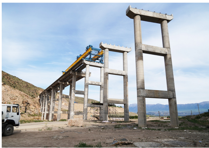
2019年5月23日，吉尔吉斯斯坦贾拉拉巴德州第二特大桥的架梁现场 马晓成/摄
