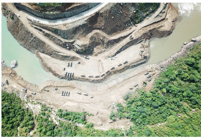
2018年9月22日，在巴基斯坦旁遮普省卡洛特地区，中巴经济走廊首个水电投资项目——卡洛特水电站工程准备进行大江截流作业 刘天/摄
